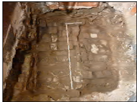
Paviment UE-17, des del sud
