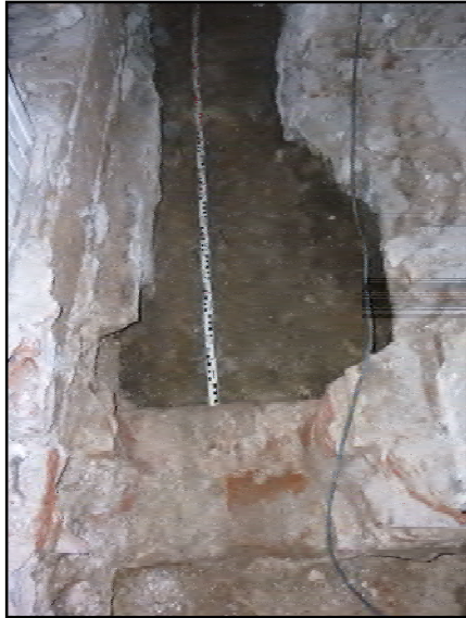
Fonamentació UE-13, a la zona de la porta d'accés a l'espai
