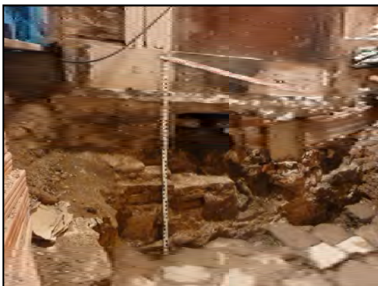
Mur UE-12 i la seva fonamentació UE-13
