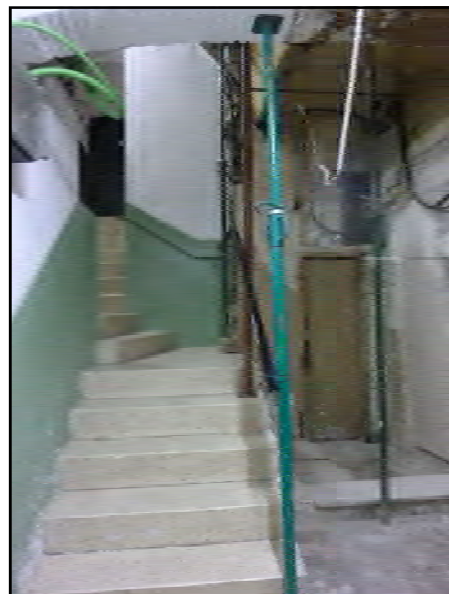
Zona de l'escala, amb els dos àmbits un cop desmuntat l'envà
